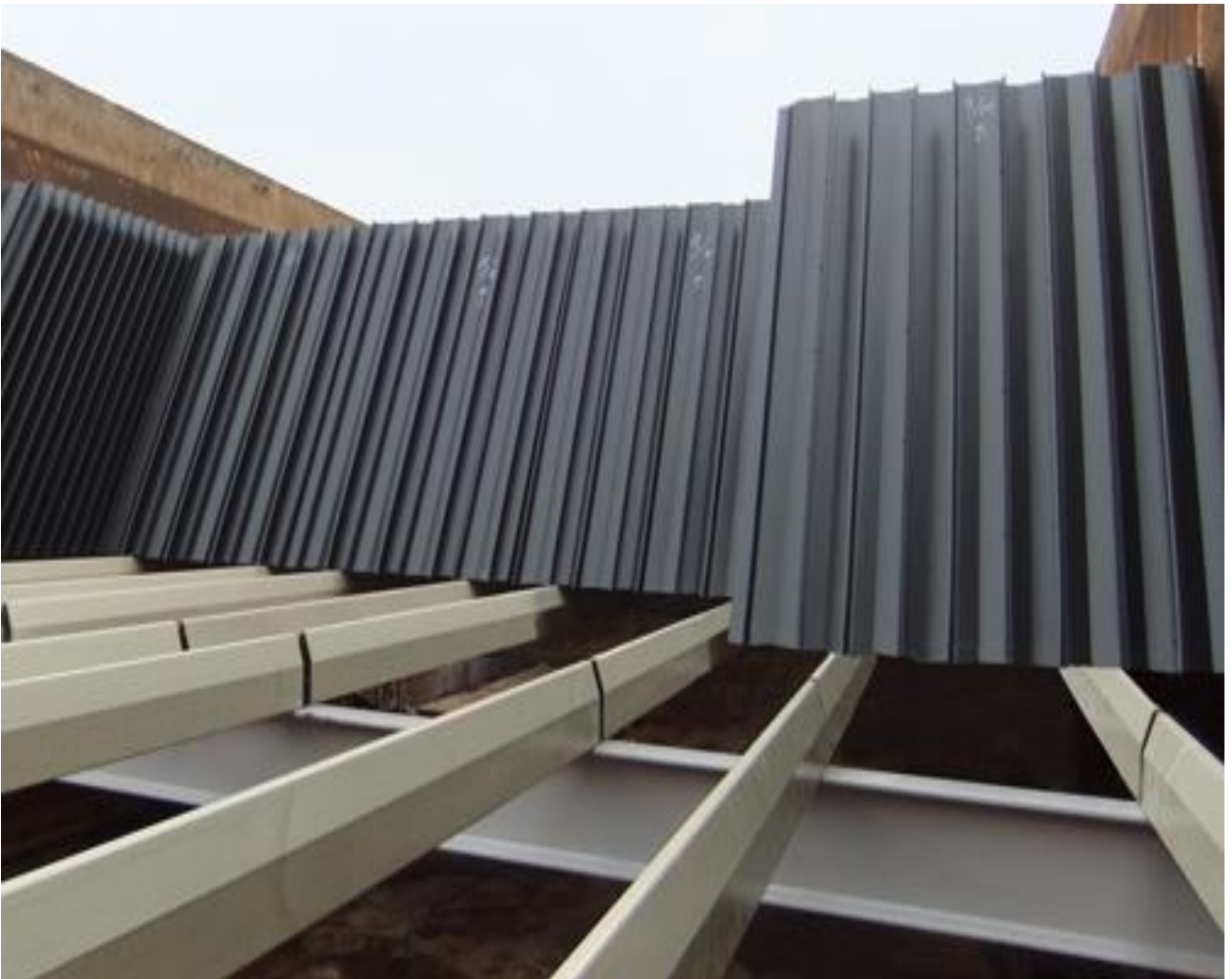
Sistema de soporte FRP debajo de módulos TUBEdek®
